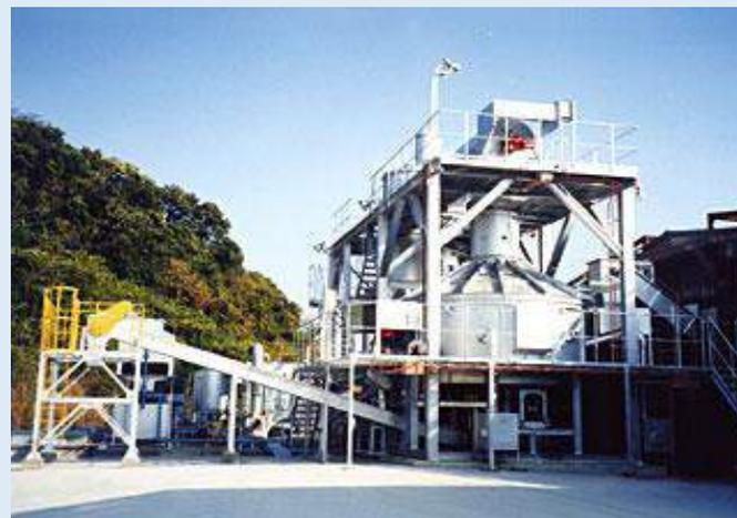
炉床回転式焼却炉
