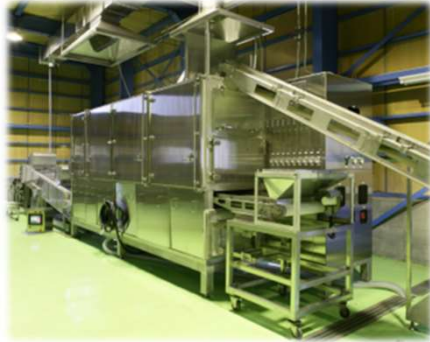
エースシステム株式会社 「全自動連続蒸気炊飯システム」 府大との共同研究により 理論的裏付けを解明
